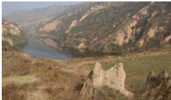
Un barrage de rétention sur le plateau de Loess en Chine piège les sédiments jusqu'à ce qu'il soit entièrement rempli. Il est ensuite utilisé pour la production de céréales. Photo: Hanspeter Liniger
